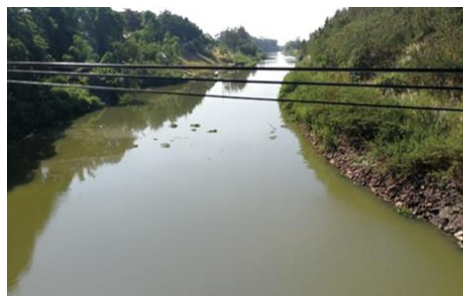
MN01 สะพานบ้านท่าวังหิน ต.แจระแม อ.เมือง จ.อุบลราชธานี
