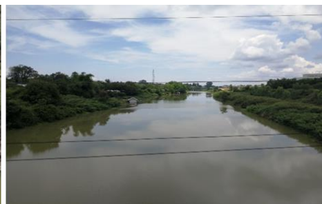
MN02 สะพานบ้านท่าบ่อ ต.แจระแม อ.เมือง จ.อุบลราชธานี
