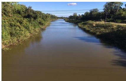
LSB03 สะพานบ้านท่าวาริ ต.หัวดอน อ.เชียงโน จ.อุบลราชธานี
